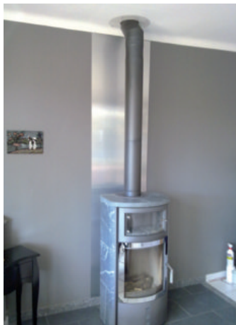
Panneau composite, couleur inox, aspect brossé, utilisé pour protéger contre le jaunissement de la peinture derrière une cheminée.
