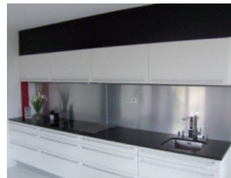
Crédence en panneau composite, couleur argent aspect brossé, collé sur placoplatre.
